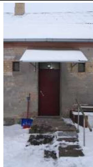
Kāpņu telpas ārdurvis
