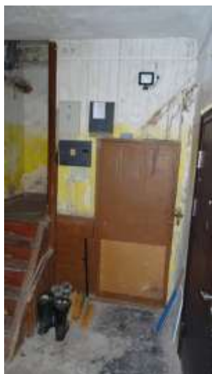
Kāpņu telpas ārdurvis
